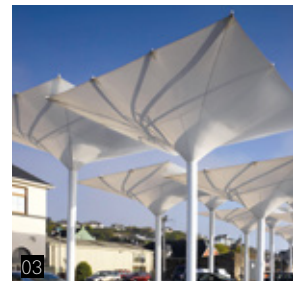
03 _ Dachlandschaft von unten. Roof top from below.
