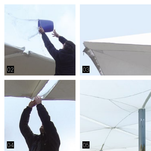
02 _ Reißverschlusstest. Zipper test. 03 _ Reißverschlussdetail. Zipper detail. 04 _ Schließen der Reißverschlüsse. Zipper closures. 05 _ Komplett geschlossene Dachlandschaft. Completely closed canopy landscape.
