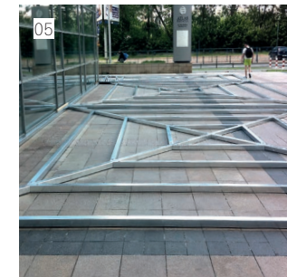
06 _ Befestigung der Verankerungsplatte auf der Unterkonstruktion des Eventbodens. The anchor plate attachment to the substructure of the elevated floor
