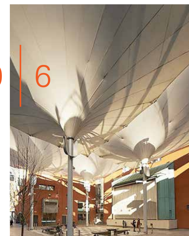
03-06 | Der Schließprozess der Schirme ist ein komplexer kinetischer Vorgang. Wichtig im Designprozess war die Einbettung der unterschiedlichen Längen des Gestänges und die Einbettung aller kinetischen Elemente in geschlossenem Zustand des Schirms. / The retraction process is a complex kinetic action. Central to the design was the control of the inevitable variance in canopy spoke lengths, so that all kinetic elements are compositionally aligned in the closed umbrella position.
