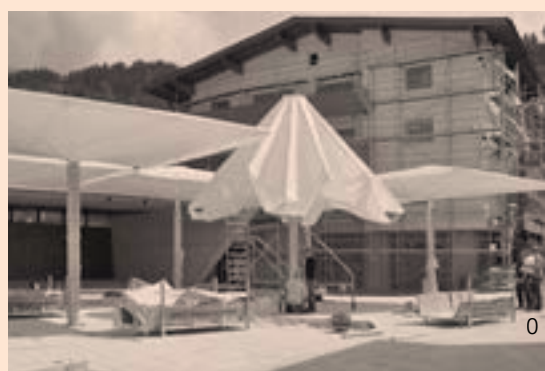
02 | Beim Öffnen sind die beiden Membranen an den Enden der Streben verbunden. / When opening, both membranes are connected at the end of the spokes.
